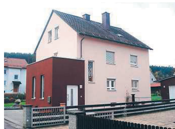
Mit einer Sanierung der Gebäudehülle inklusive Fenster und Vollwärmeschutz lässt sich der Energieverbrauch eines Altbaus drastisch reduzieren. Foto: Haberer
